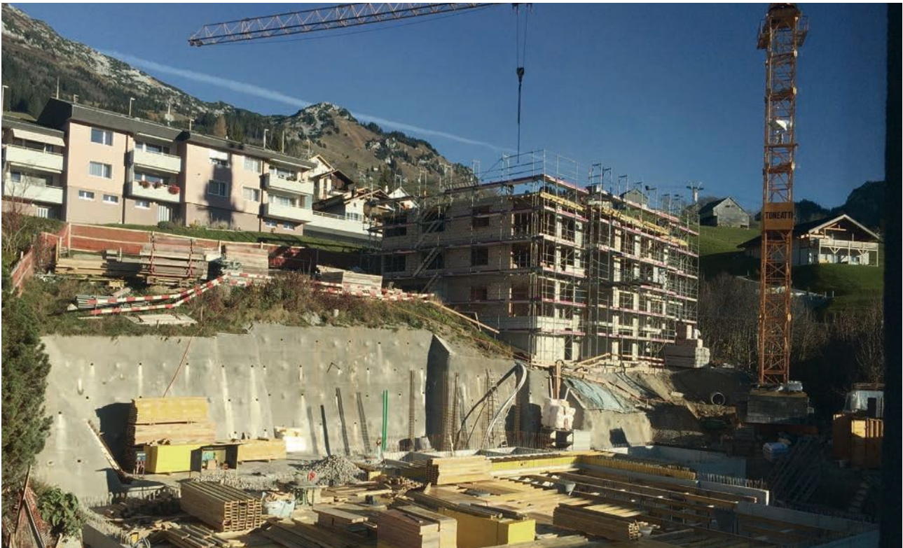
Am Grund der 14 Meter tiefen Baugrube liegt der Verbindungsgang, darüber die Tiefgarage.
