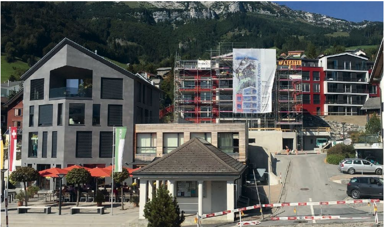
Dorfkern Amden im Frühling 2016: Im Bau das Haus West (mit Baureklame), bereits fertig das Haus Ost (rechts).
